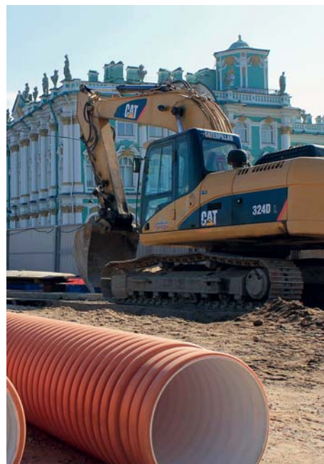
Реконструкция Дворцового моста
